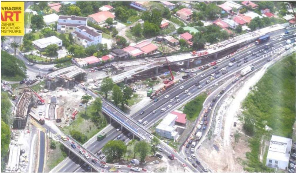
© EFFAGE TP GRANDS TRAVAUX
